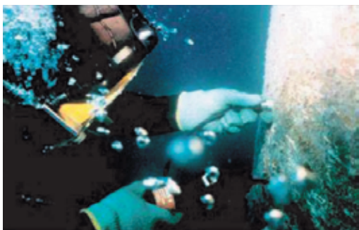
Рис.1. Осмотр дайвером опоры моста
