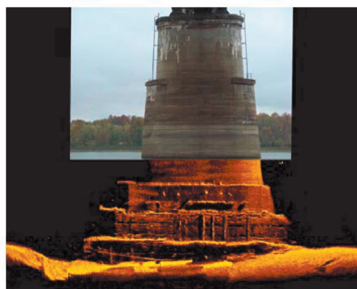
Рис. 8. Изображения опор одного из мостов в штате Айова, полученные с помощью акустических приборов. Инспекция проводилась после наводнений на Среднем Западе США в 2008 году
