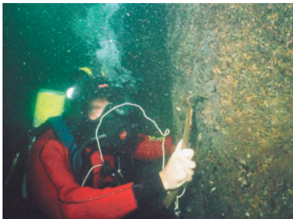
Рис.4. Очистка дайвером бетонной поверхности подводного элемента моста с помощью ручного скребка
