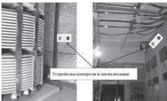
Рис. 10. Варианты установки стационарного устройства контроля и сигнализации тяговой подстанции
