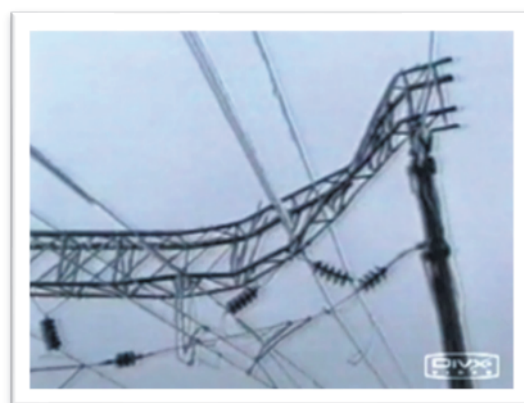
Рис.2. Последствия «гололедного дождя». Станция Кривенковская Северо-кавказская железная дорога
